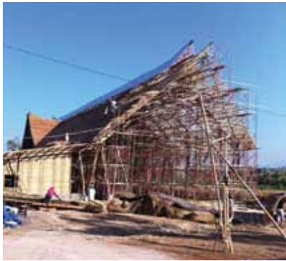
Tvornica čokolade tijekom građenja
