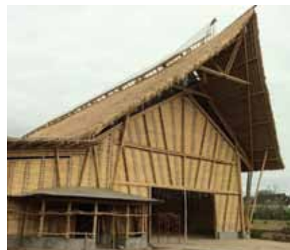
Novoizgrađena tvornica čokolade u Sibangu
