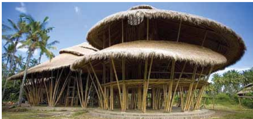
"Zelena" škola na Baliu u cijelosti izgrađena od bambusa
