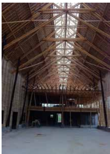
Detalj unutrašnjosti tvornice čokolade
